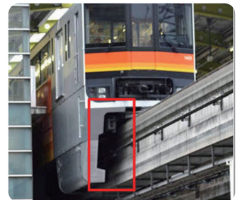
モノレールの軌道ガイドレール
